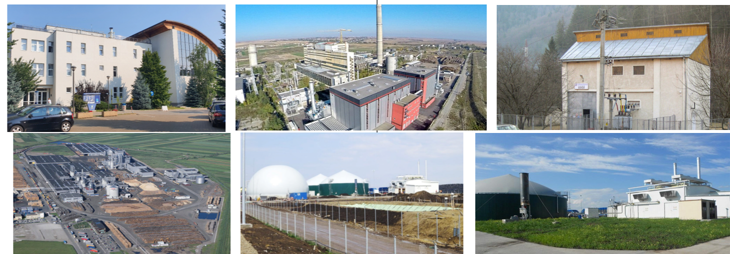
Electrical and thermal power plants using renewable sources. Centrale de producere a energiei electrice și termice din surse regenerabile.
